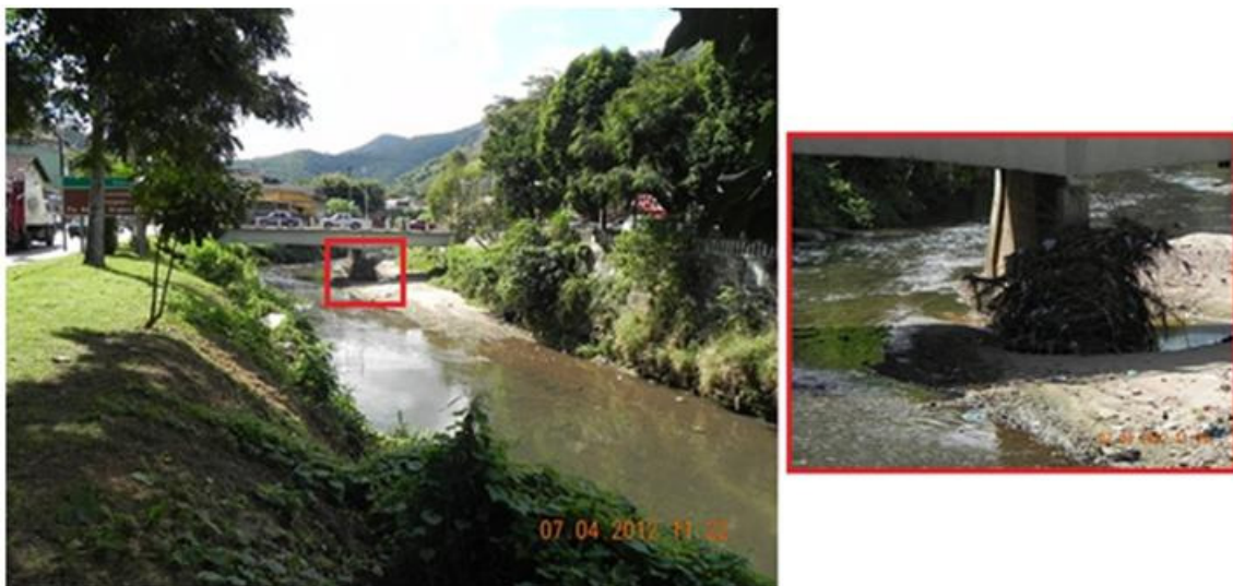
Figura 48: Visões de montante e de jusante de P22, respectivamente.
