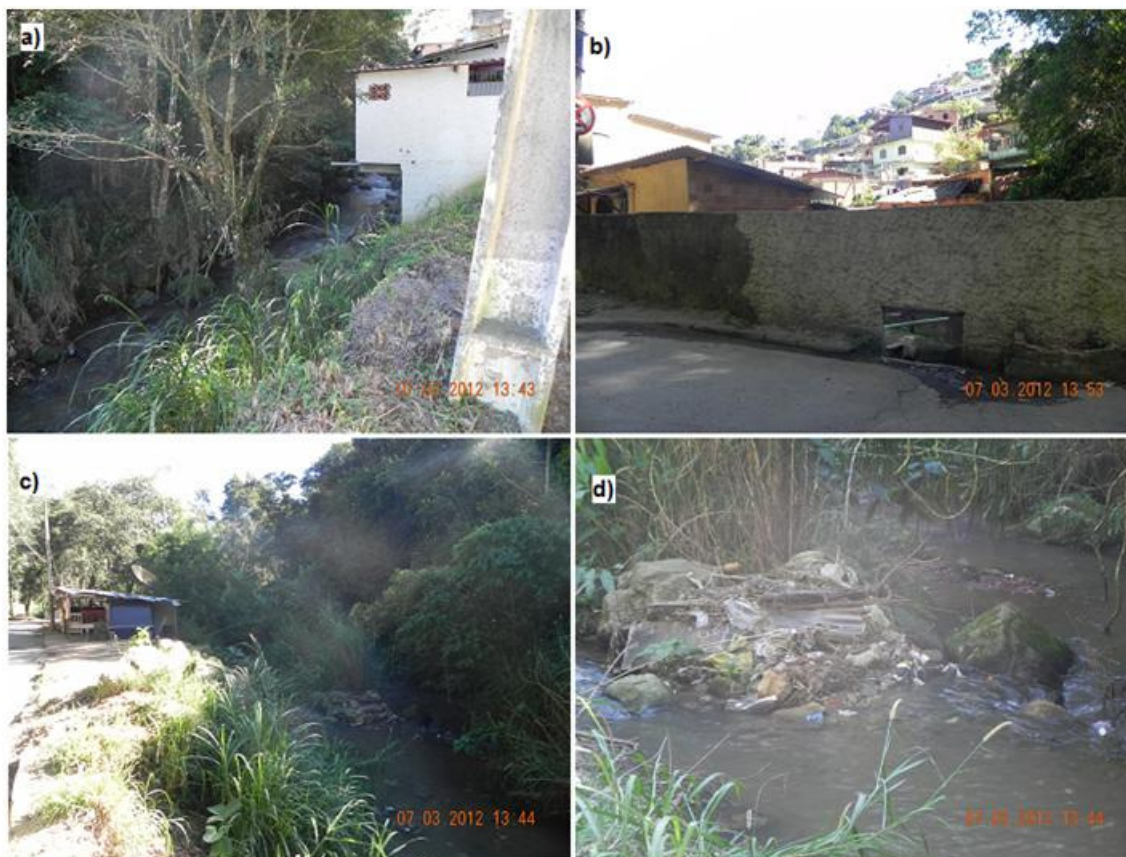
Figura 28: a) Foto a montante de P09; b) Foto ilustrando a comunidade e a contribuição direta no rio Piabanha; c) Foto de uma pequena "ilha" formada a jusante de P09; d) Ampliação da “ilha” formada na calha do rio Piabanha.
