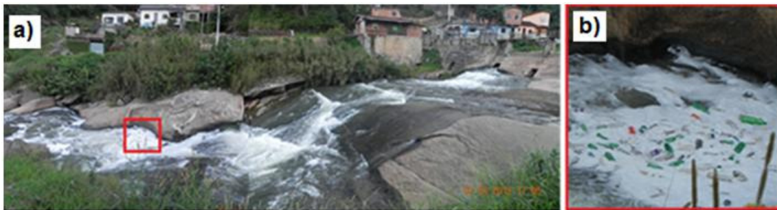
Figura 43: a) Foto panorâmica ilustrando o escoamento a jusante do vertedor; b) Foto ilustrando o acúmulo de garrafas PET em um bolsão de água.
