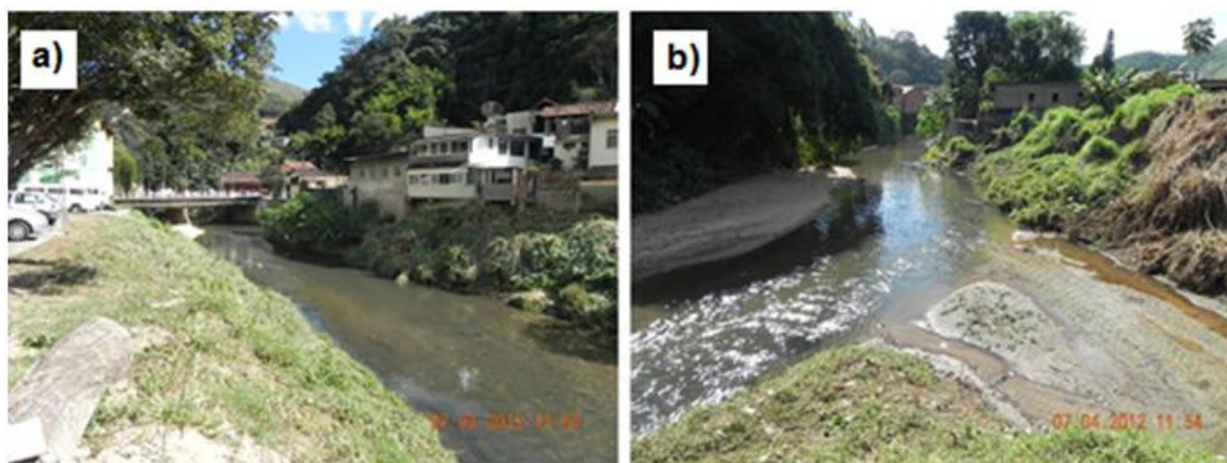
Figura 49: a) Visão de montante da confluência entre os rios Bonfim e Piabanha; b) Visão da confluência entre os rios e de jusante da mesma.
