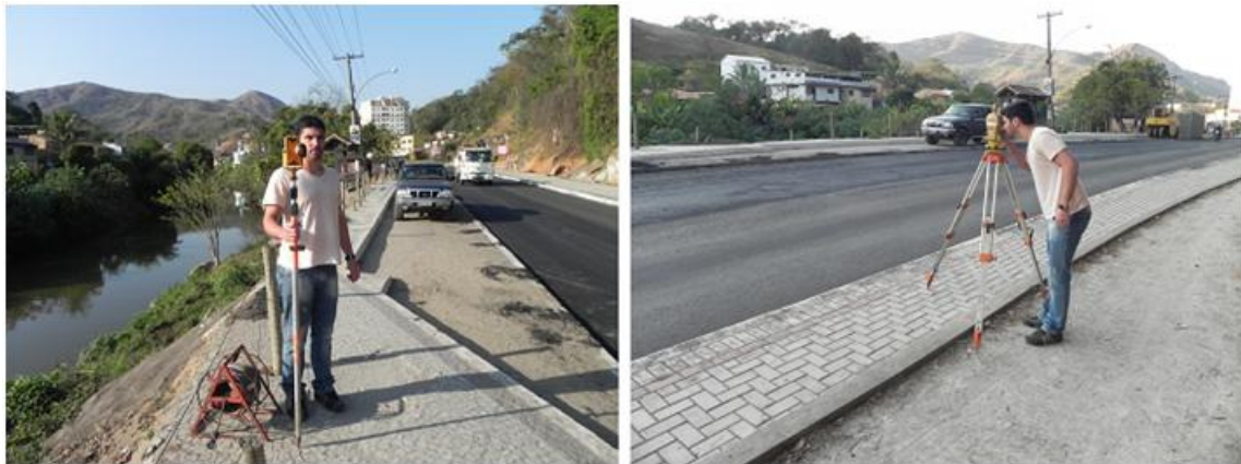
Figura 81: Foto tirada na Seção 19 quando se estava mirando o prisma, para se determinar a cota nos pontos selecionados da seção transversal.
